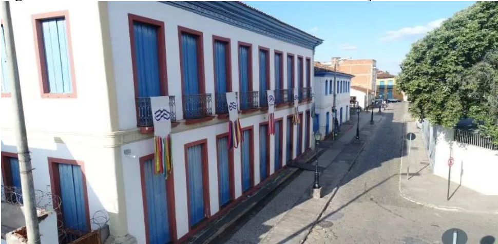
Figura 40 – Rua Coronel Celestino revitalizada em março de 2012
