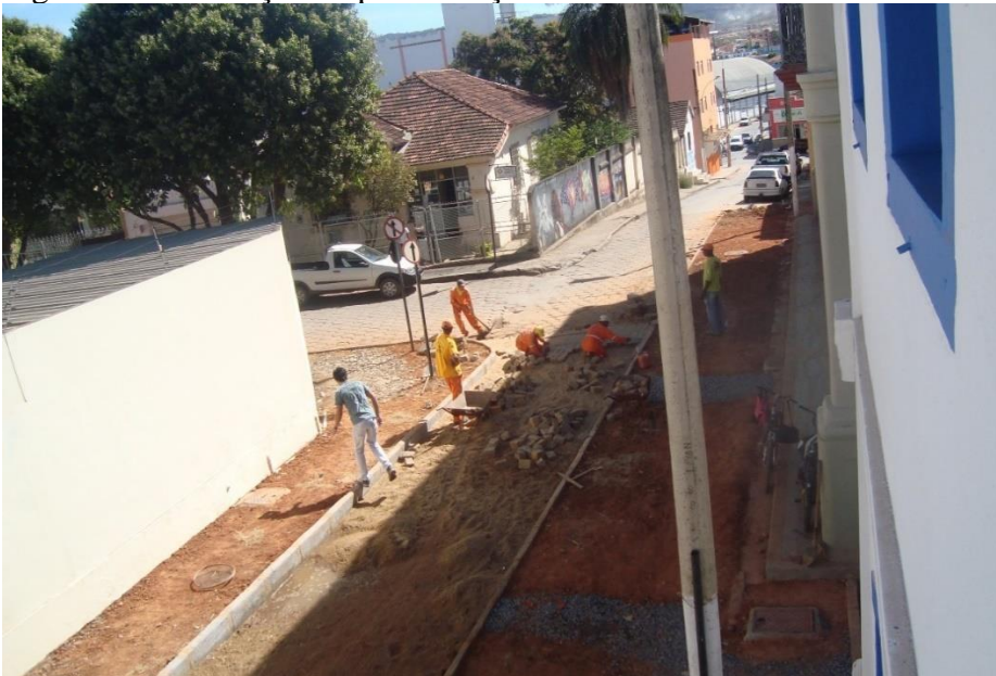
Figura 38 - Instalação de piso e calçamento na rua Coronel Celestino em 2012
