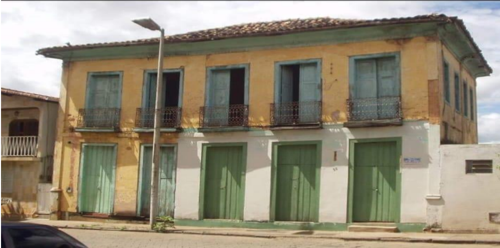
Figura 22 - O Casarão em estado avançado de deterioração, durante o século XX
