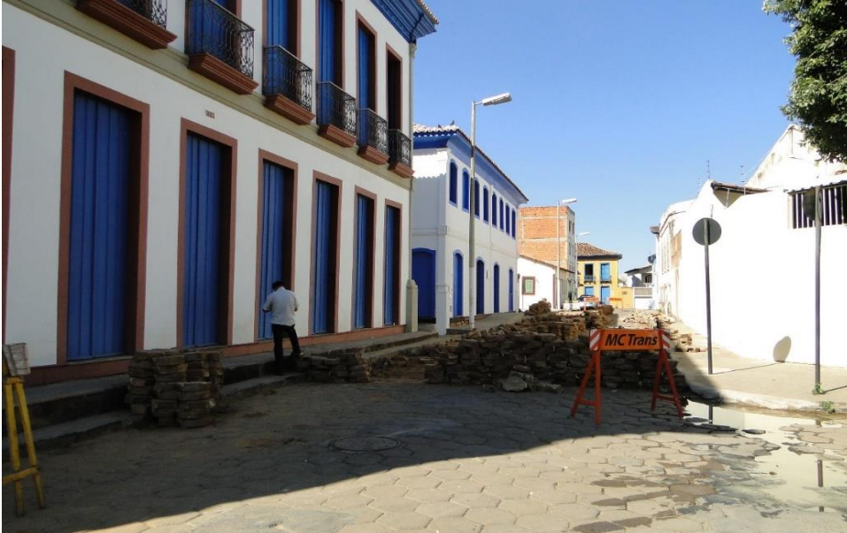
Figura 39 - Revitalização da rua Coronel Celestino sendo finalizado em março de 2012
