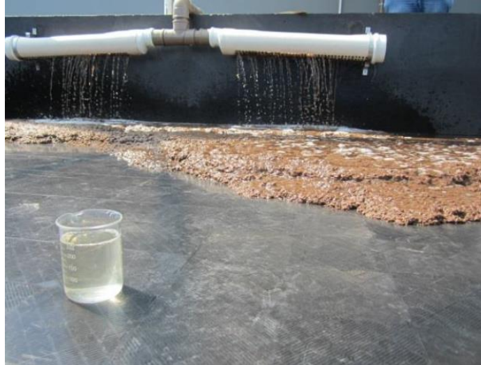
Figura 8 - Desaguamento do efluente em bloco drenante.
