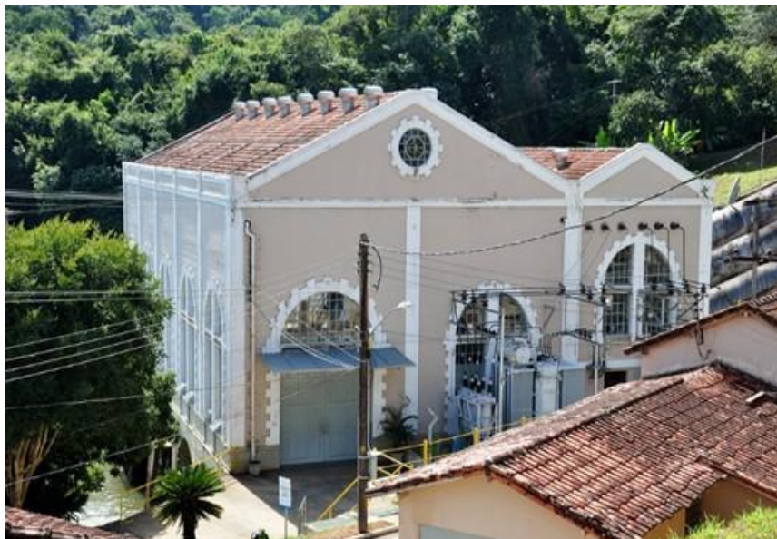
FIGURA 6 – Registro da Usina Hidrelétrica Jaguari
