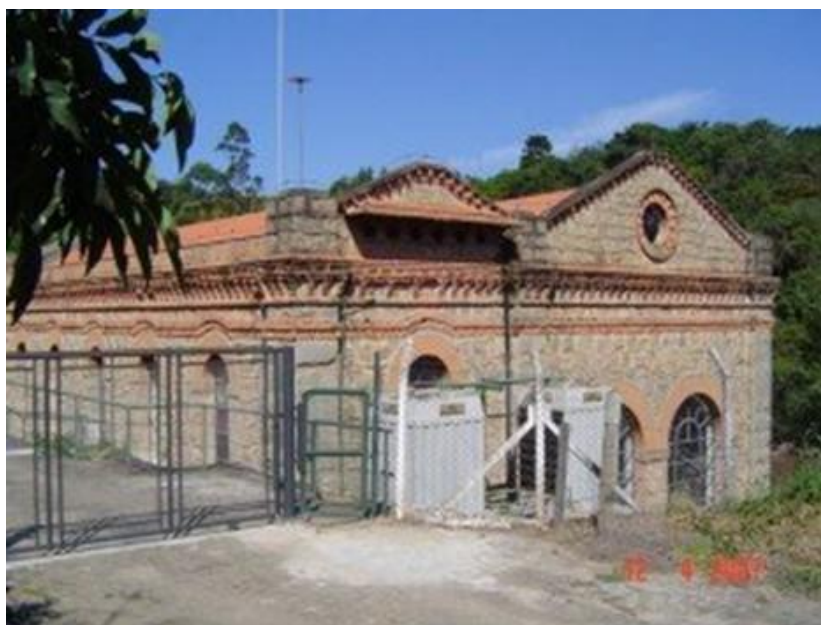
FIGURA 5 – Registro da Usina Hidrelétrica Salto Grande
