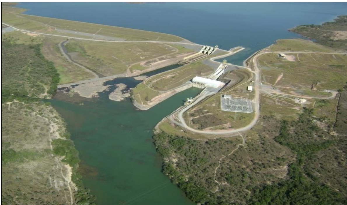
Figura 4. Vista geral do empreendimento da Usina Hidrelétrica de Retiro Baixo.
