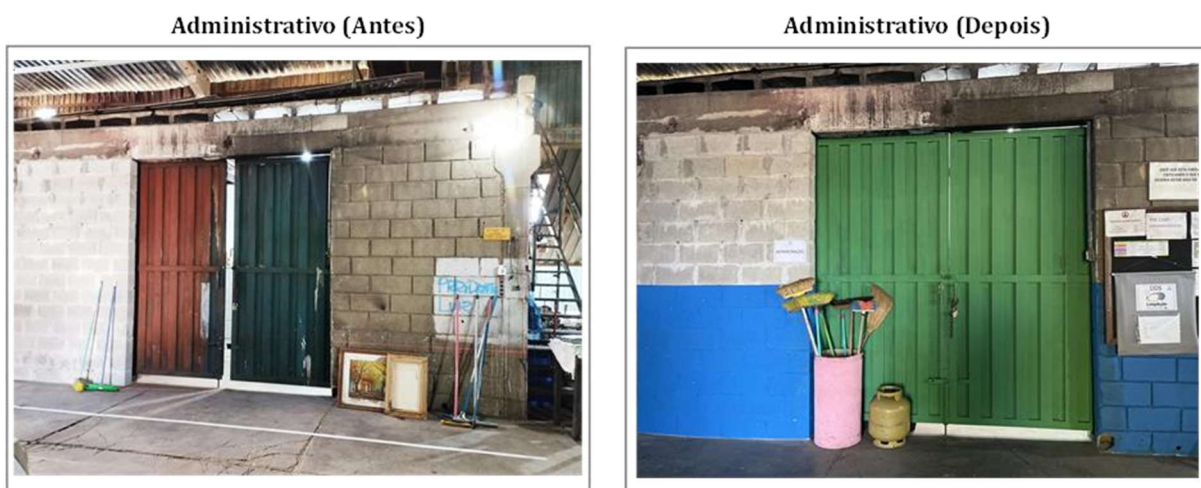
Figura 8 – Renovação da pintura do galpão
