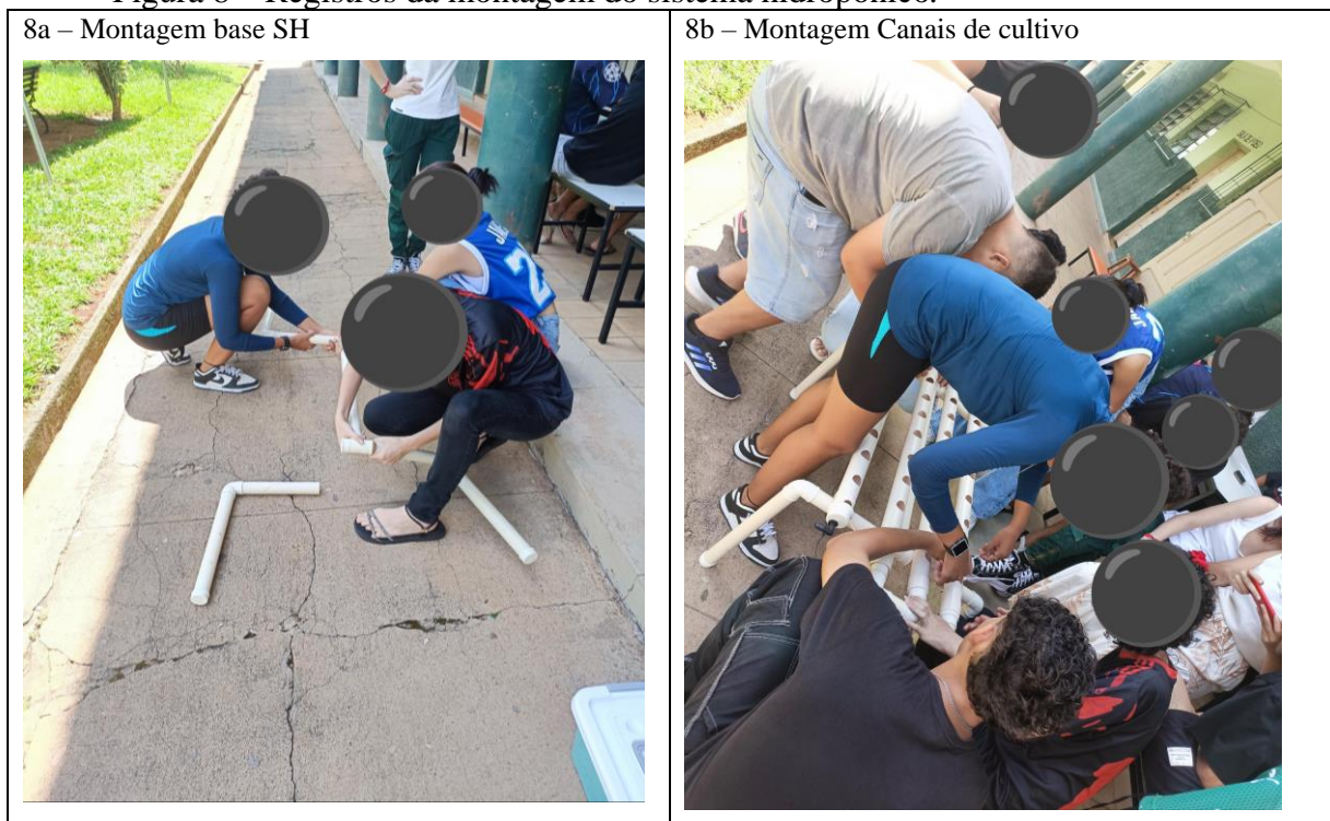
Figura 8 – Registros da montagem do sistema hidropônico.
