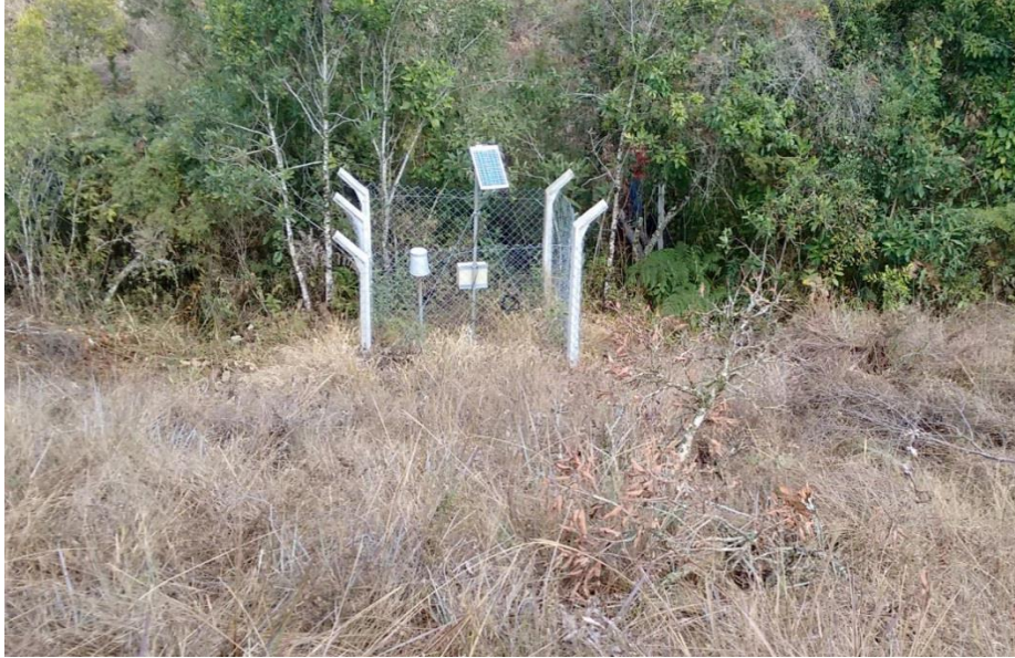
Figura 11 - Estação Hidrossedimentométrica instalada na BHCG. Fonte: Do Autor.
