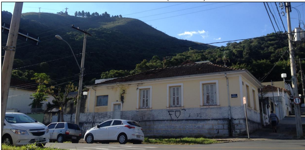
FIGURA 17 - Controle de altimetria na ZPE-1 (Rua Pará).
