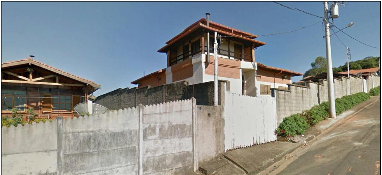
FIGURA 16 - Residências no Santa Cruz.
