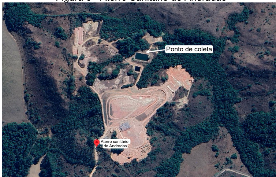
Figura 3 - Aterro Sanitário de Andradas
