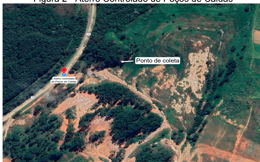
Figura 2 - Aterro Controlado de Poços de Caldas
